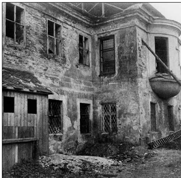
Částečný pohled na zničený klášter. Foto archiv NPÚ Brno.
