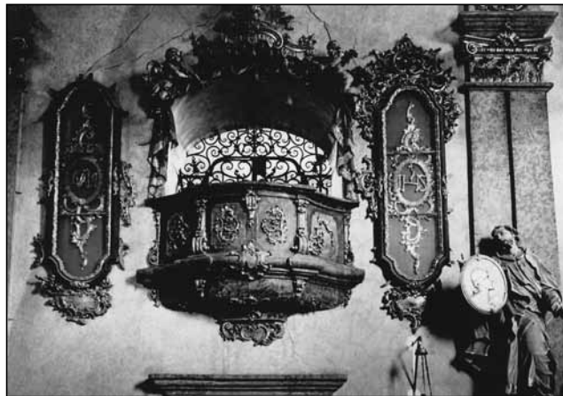
Část bývalé výzdoby kostela – pravá oratoř. Foto archiv SZM Opava, stav kolem r. 1930.
